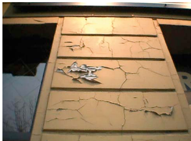
Fig. 10 Vieillessement d'une peinture à base de résine alkyde.
