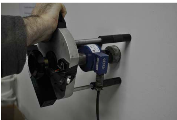
Fig. 22 Essai d'arrachement pull-off selon la norme NBN EN 1504-2 [B21].
