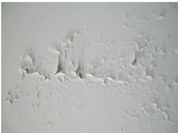
Fig. 9 Vieillessement d'une peinture à base de résine vinylique.
